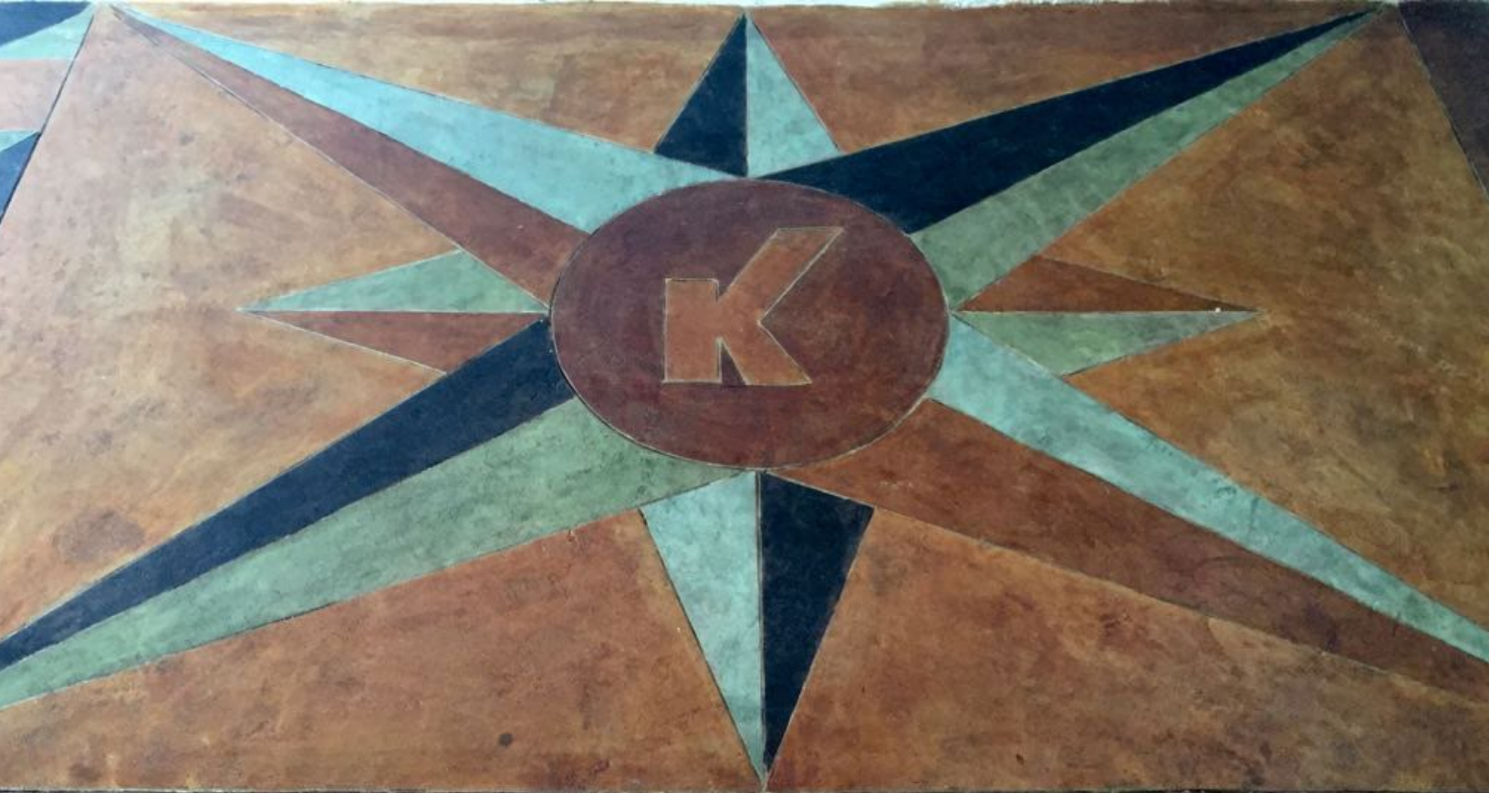
Piso con concreto oxidado
